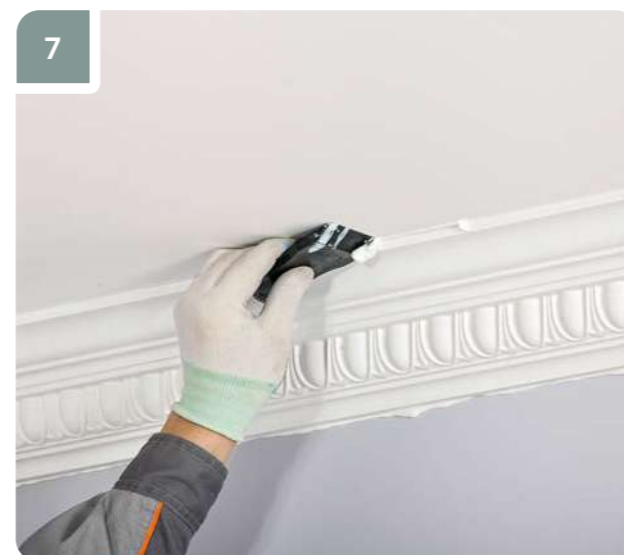
7 Сразу после приклеивания удалить выступившие излишки клея штапелем.
