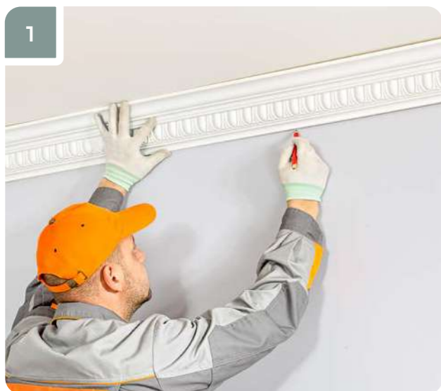
1 Плотно прижать изделие к стене и потолку, сделать отметки по нижнему краю изделия.
