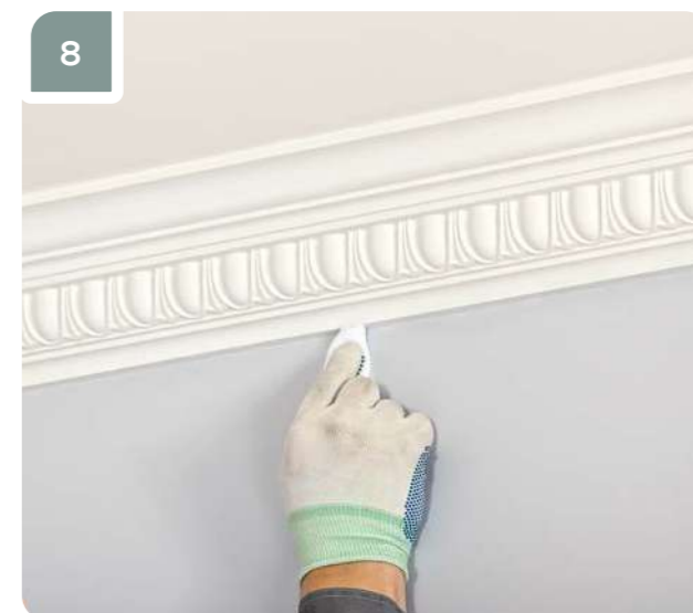
8 При необходимости места примыкания изделия к стене и потолку протереть ветошью, смоченной водой — при использовании клея «Европласт Монтажный», ацетоном — при использовании клея «Европласт Универсальный».
