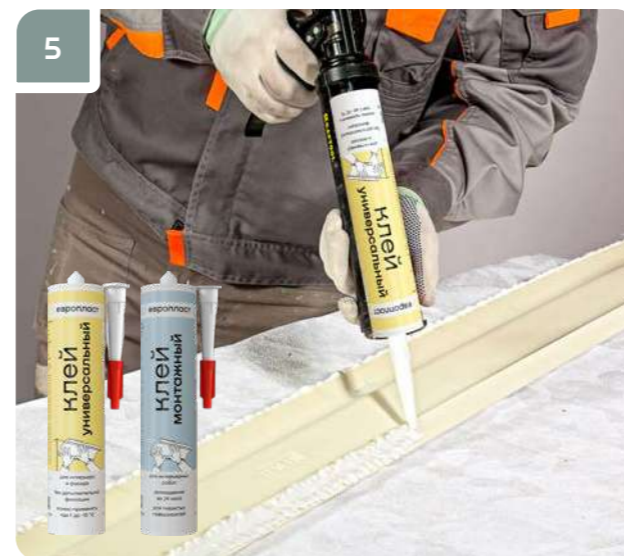
5 Равномерно нанести на монтажную поверхность клей «Европласт Монтажный» или «Европласт Универсальный» по всей длине изделия. Толщина наносимого слоя клея должна составлять 3–5 мм.
