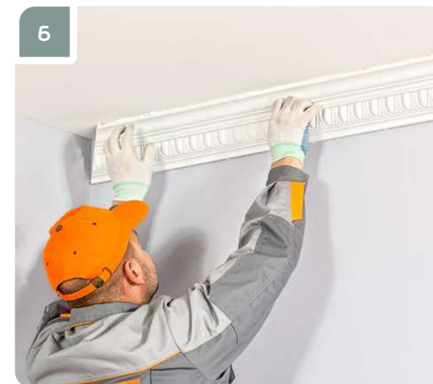
6 Приложить изделие к месту установки согласно разметке на стене. Прижать изделие по всей длине, чтобы клей выступил из-под всей плоскости примыкания.
