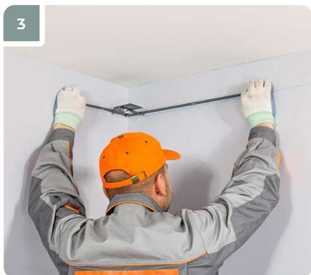
3 С помощью угломера произвести замер угла помещения.
